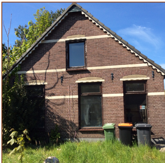
Afb. 2: Te slopen woning. Er zijn geen vaste, jaarrond beschermde verblijfplaatsen aangetroffen.
