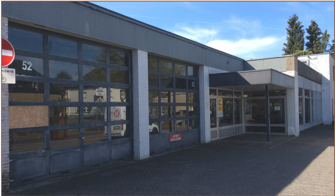
Afb. 2.1: Voorgevel bedrijfspand gezien vanaf de kruising Dorpsstraat - Ter Heerdtspad.
