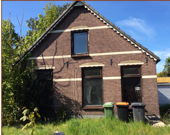
Afb. 2.2: Vrijstaande woning aan de westelijke rand van het terrein. Rechts op de achtergrond is nog net een deel van de garage te zien. De woning is geschikt voor vleermuizen, nader onderzoek is noodzakelijk.
