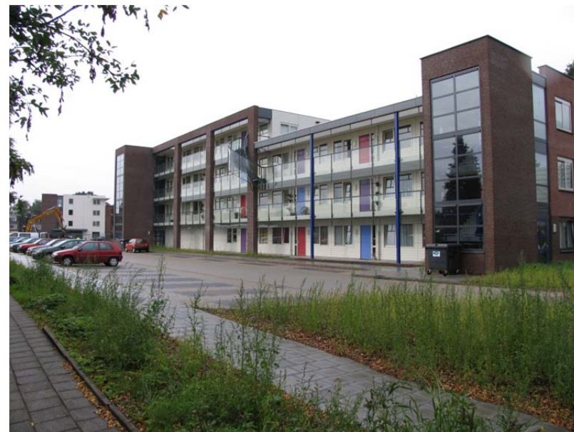
Nieuwbouw appartementen aan westzijde Vogelbuurt
