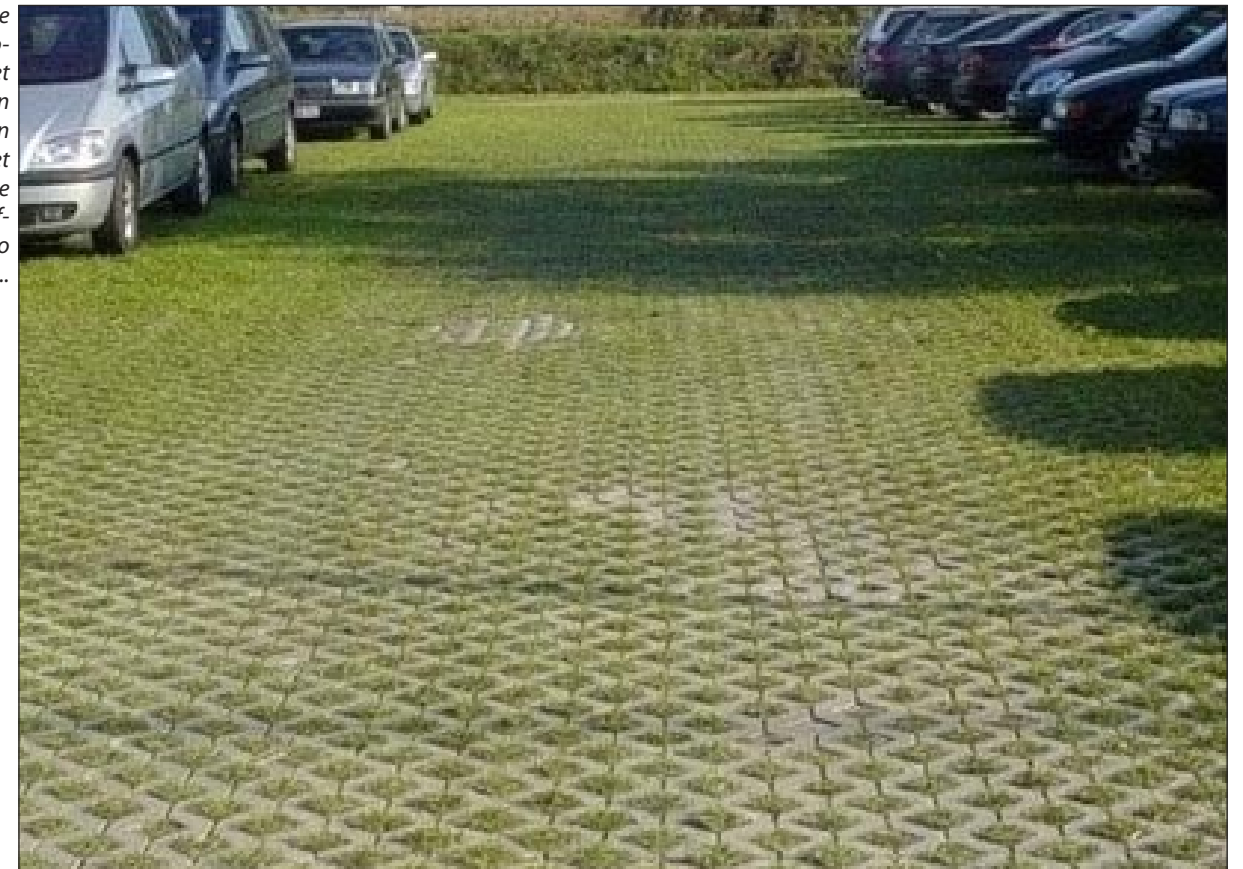
Afb 3.3 : Regenwater moet ter plaatse van de enk infiltreren in de bodem, gelijk aan de huidige situatie. Een parkeerplaats met een open verharding maakt dit mogelijk.
