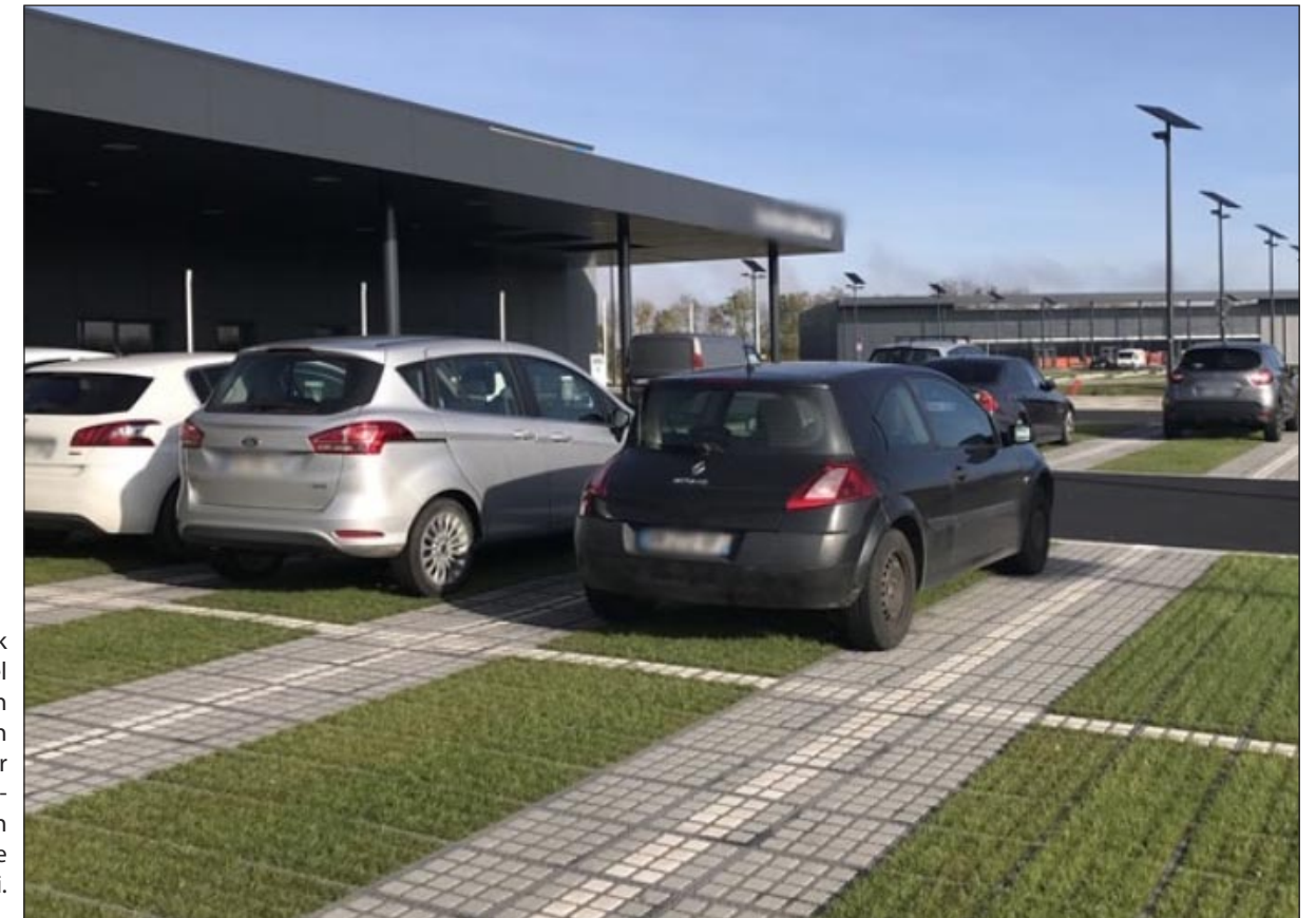
Afb 3.4: Waar de parkeerdruk minder hoog is, maar nog wel intensief in gebruik, zijn 'groene' parkeerplaatsen mogelijk. De rijbaan krijgt dan een volledige verharding. Regenwater kan infiltreren in het parkeervak of stroomt af naar de buitenzijde waar het in de singel kan wegzakken.
