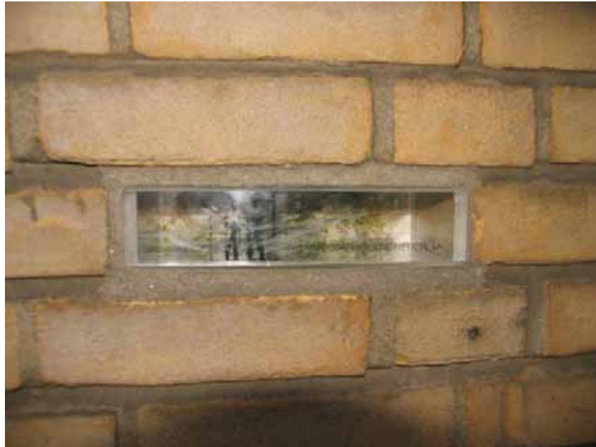
Afbeelding 4: opengewerkte muur met toezicht op de aangebrachte spouwmuurisolatie.
