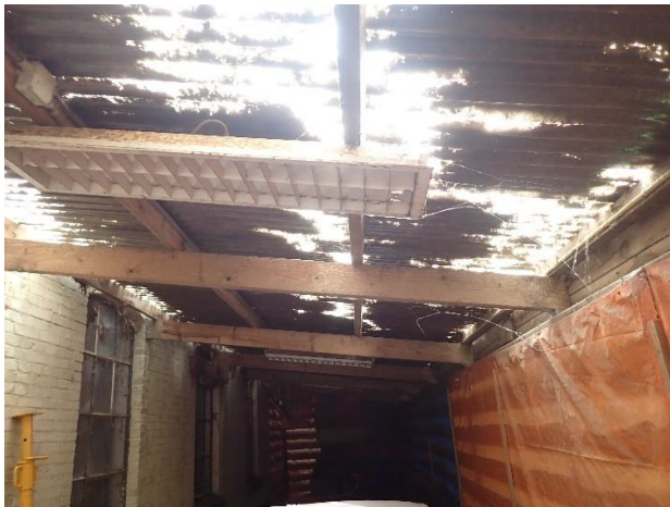
Foto 5: links, binnenkant carport die vastzit aan de loods
