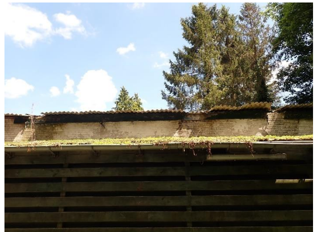
Foto 6: rechts, zijkant carport in de richting van het midden van het plangebied.
