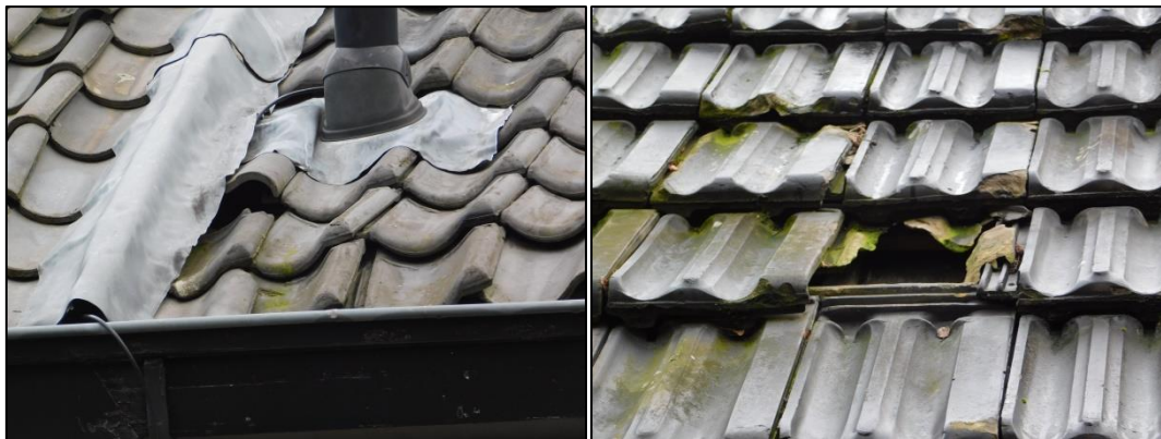
Foto's 5 en 6. Links het pannendak van het winkelpand met geschikte openingen voor huismuis. Rechts het pannendak van de vervallen opslagschuur met geschikte openingen voor huismuis.
