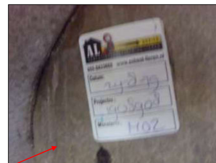
Foto 6: Opslag, 1 e etage: Buis (Bron 2) (Asbesthoudend)
