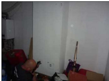
Foto 81: Schoorsteenkanaal (Niet asbestverdacht)
