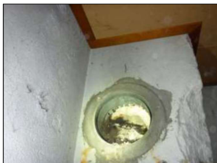
Foto 95: Schoorsteenkanaal (Niet asbestverdacht)
