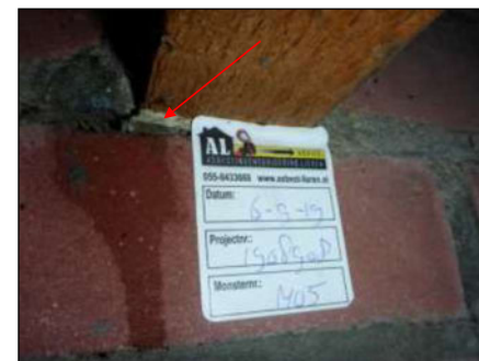
Foto 18: Garage, binnenzijde: Vulplaatjes (Bron 5) (Asbesthoudend) Zie conclusie hoofdstuk 7.
