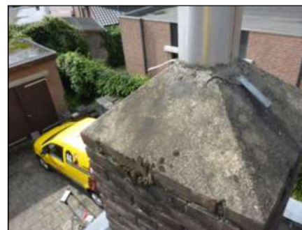
Foto 101: Schoorsteenkanaal (Niet asbestverdacht)
