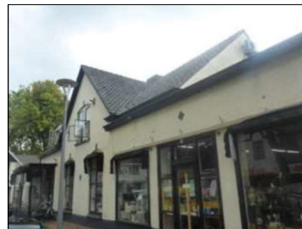
Foto 1: Bedrijfspan & opstallen, Stationsstraat 10-12 te Epe
