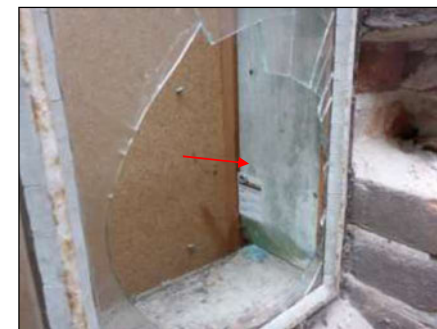
Foto 26: Opslag: Kozijnbetimmering (Bron 6) (Asbesthoudend)
