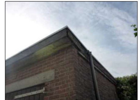
Foto 38: Garagebox: Hemelwaterafvoer (Niet asbestverdacht)
