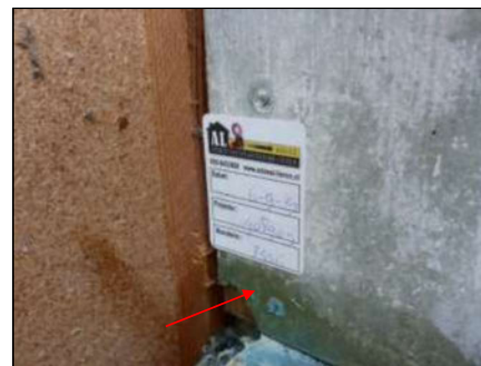
Foto 25: Opslag: Kozijnbetimmering (Bron 6) (Asbesthoudend)
