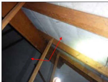
Foto 92: Pand: Dakbeschoot (Bron 9) (Asbesthoudend) Zie conclusie hoofdstuk 7.
