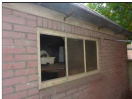
Foto 23: Garage: Stopverf (Niet asbestverdacht)
