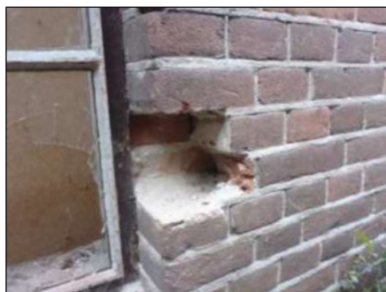
Foto 24: Garage: spouw (Niet asbestverdacht)
