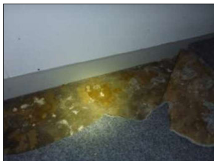
Foto 12: Opslag: Vloerafwerking (Niet asbestverdacht)
