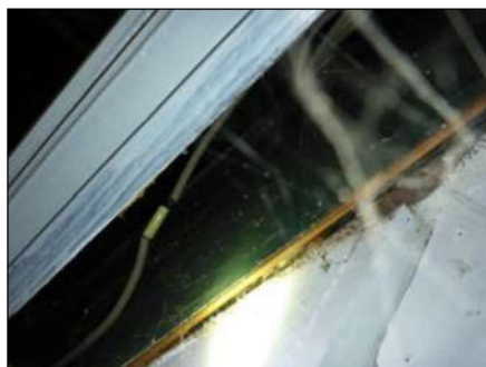
Foto 84: Achter aftimmering (Niet asbestverdacht)
