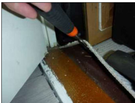
Foto 70: Onder vloerafwerking (Niet asbestverdacht)
