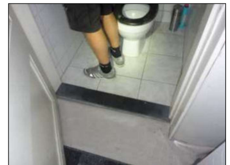
Foto 66: Toilet: Dorpel (Niet asbestverdacht)
