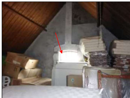
Foto 45: Opslag: Stopverf (Bron 7) (Asbesthoudend)
