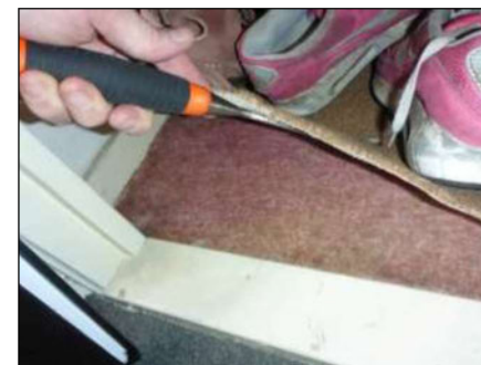
Foto 76: Onder vloerafwerking (Niet asbestverdacht)
