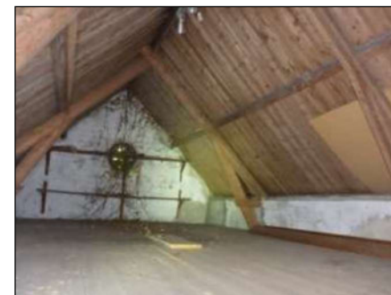
Foto 98: Schuur: 1 e etage
