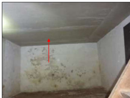
Foto 60: Pand, kelder: Verloren bekisting (Bron 9) (Asbesthoudend) Zie conclusie hoofdstuk 7.
