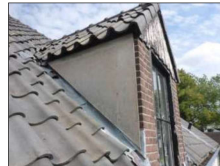
Foto 100: Pand, dakkapel: Zijwangen (Niet asbestverdacht)
