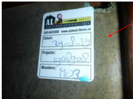
Foto 9: Opslag, 1 e etage: Deurbeplating (Bron 3) (Asbesthoudend)
