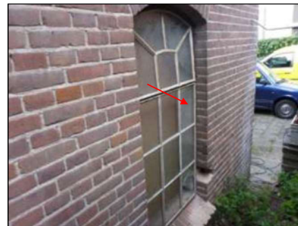
Foto 27: Opslag: Kozijnbetimmering (Bron 6) (Asbesthoudend)
