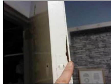
Foto 63: Deurbeplating (Niet asbestverdacht)
