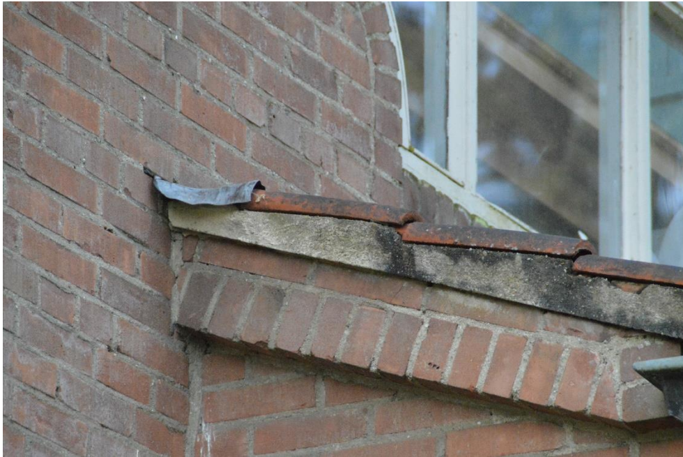
7 Ruimte achter loodslab, een potentiële verblijfplaats voor vleermuizen.
