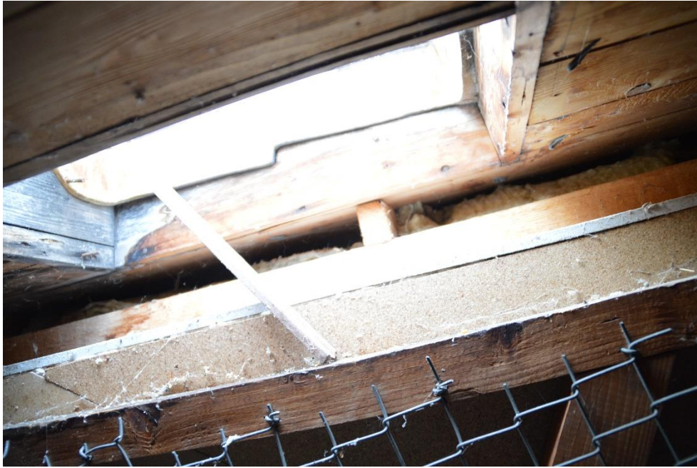
5 Isolatie tussen dakbeschoot op gebruikte zolder.
