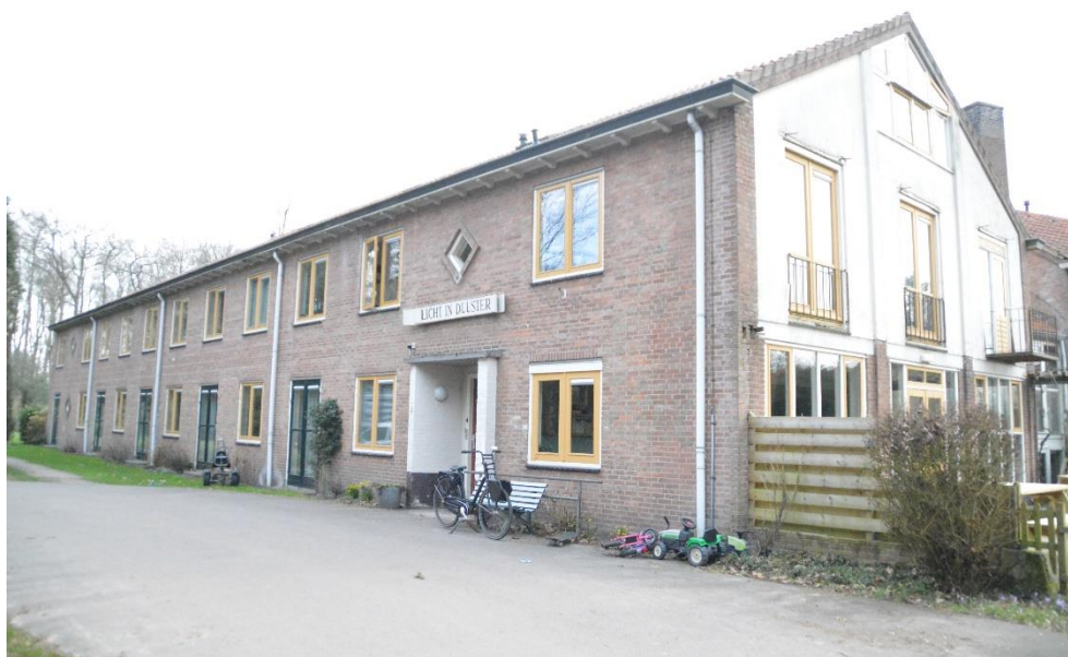
1 Het te slopen gebouw.
