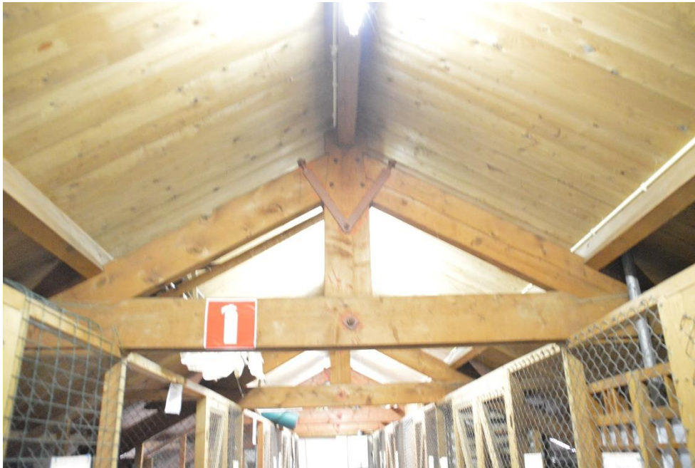
3 Zolder, deels in gebruik als opslag en een beschoten dak.
