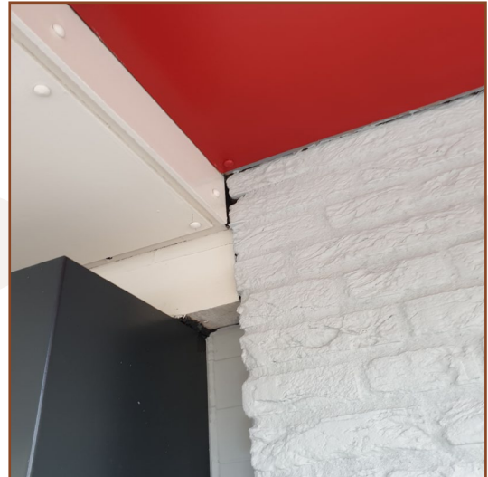
Afbeelding 8: Onder de gevelbeplating zijn ruimte aanwezig waardoor vleermuizen het pand kunnen betreden en gebruiken als vaste rust- en verblijfplaats.
