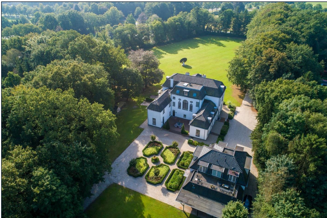
Afbeelding 2 Afbeelding van het hoofdgebouw en koetsgebouw landgoed Kolthoven. – Funda.nl
