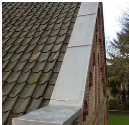
Afb. 39: Zinken daklijst op kopgevel
