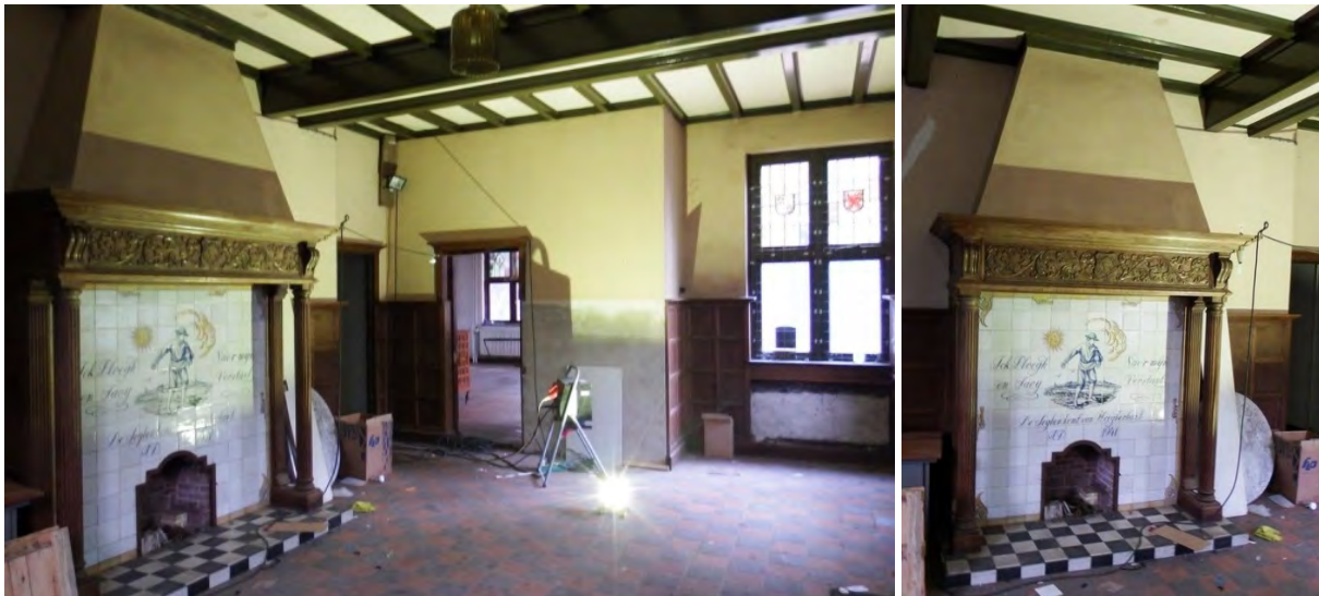
Afb. 24: Entreehal (0.01) naar het noorden met moeder- en kinderbinten plafond (links) en de schouw met het tegeltableau (rechts).
