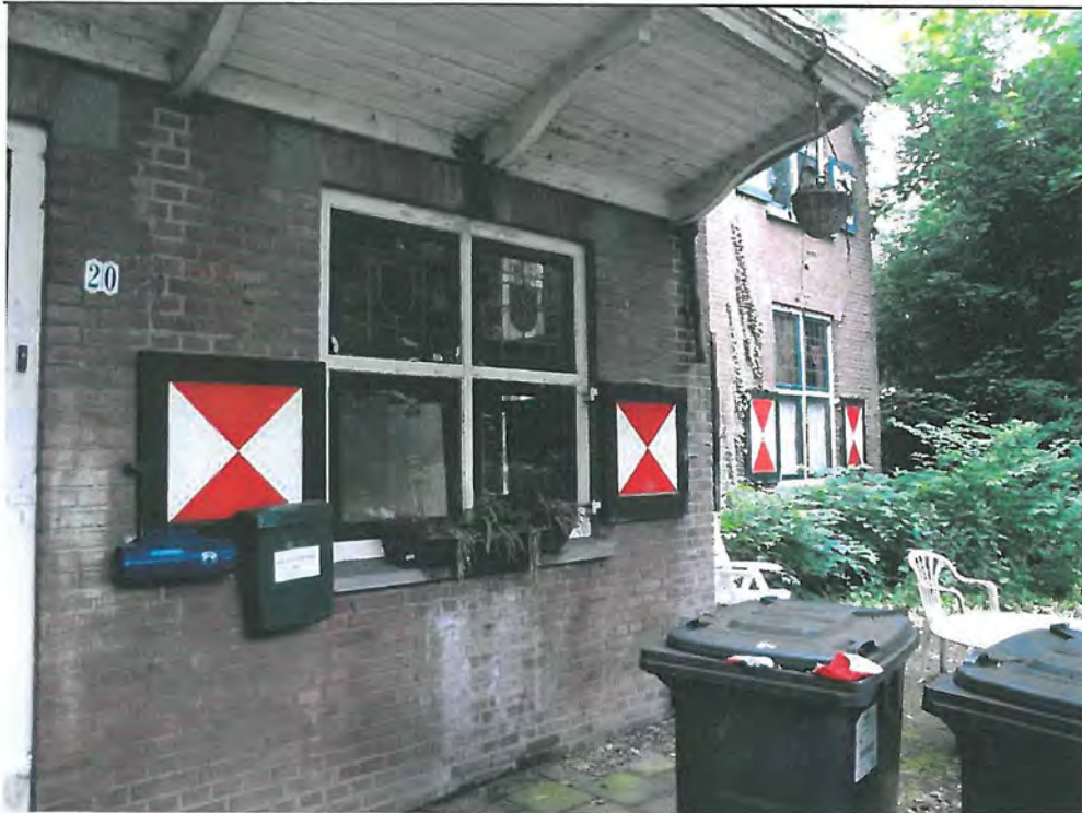
Gedeelte van voorgevel met kruisvenster en deel van luifel.
