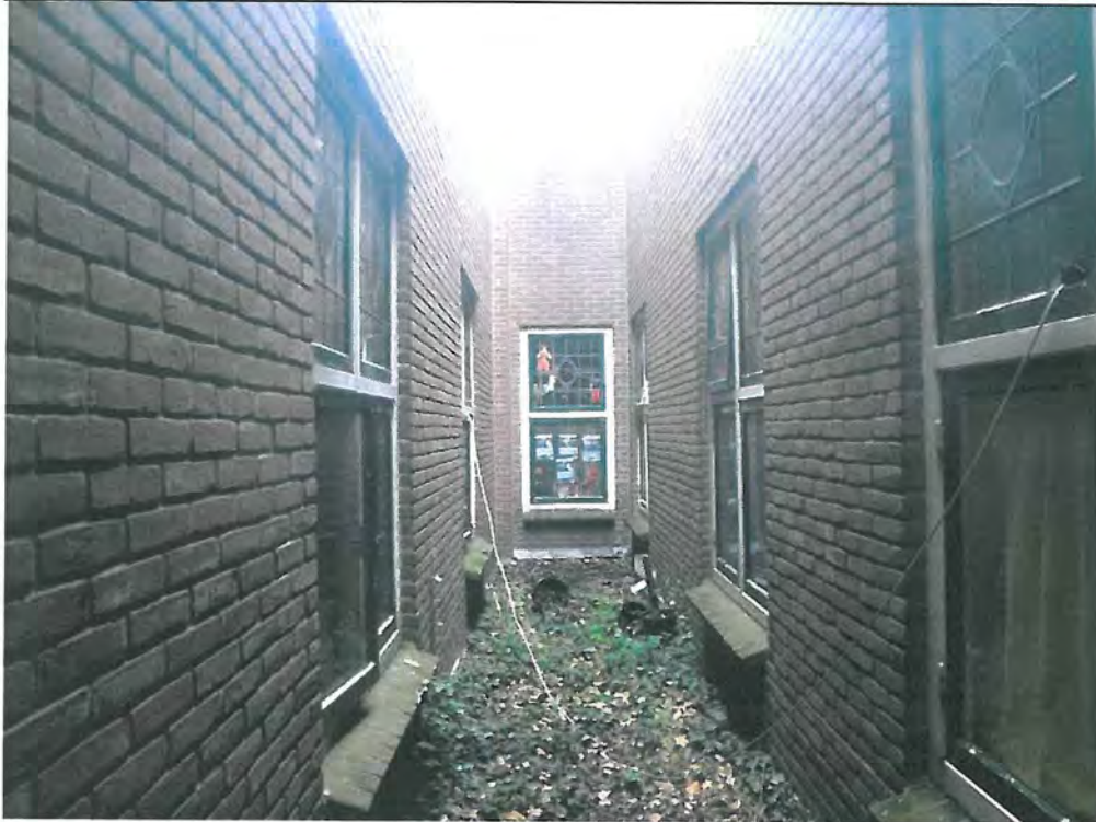
Lichtkoker op eerste verdieping; in tegenstelling tot de buitengevels is een halfsteens metselverband toegepast.
