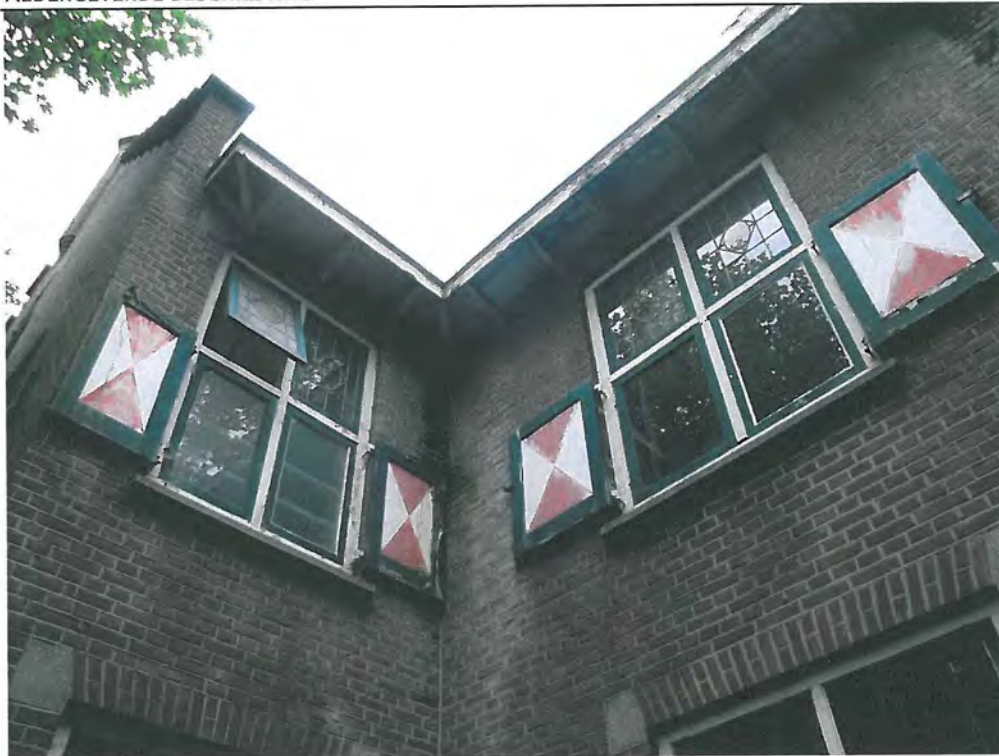
Voorgevel, aanzet van het middenrisaliet met zicht op dakoverstek en detaillering kruisvensters.
