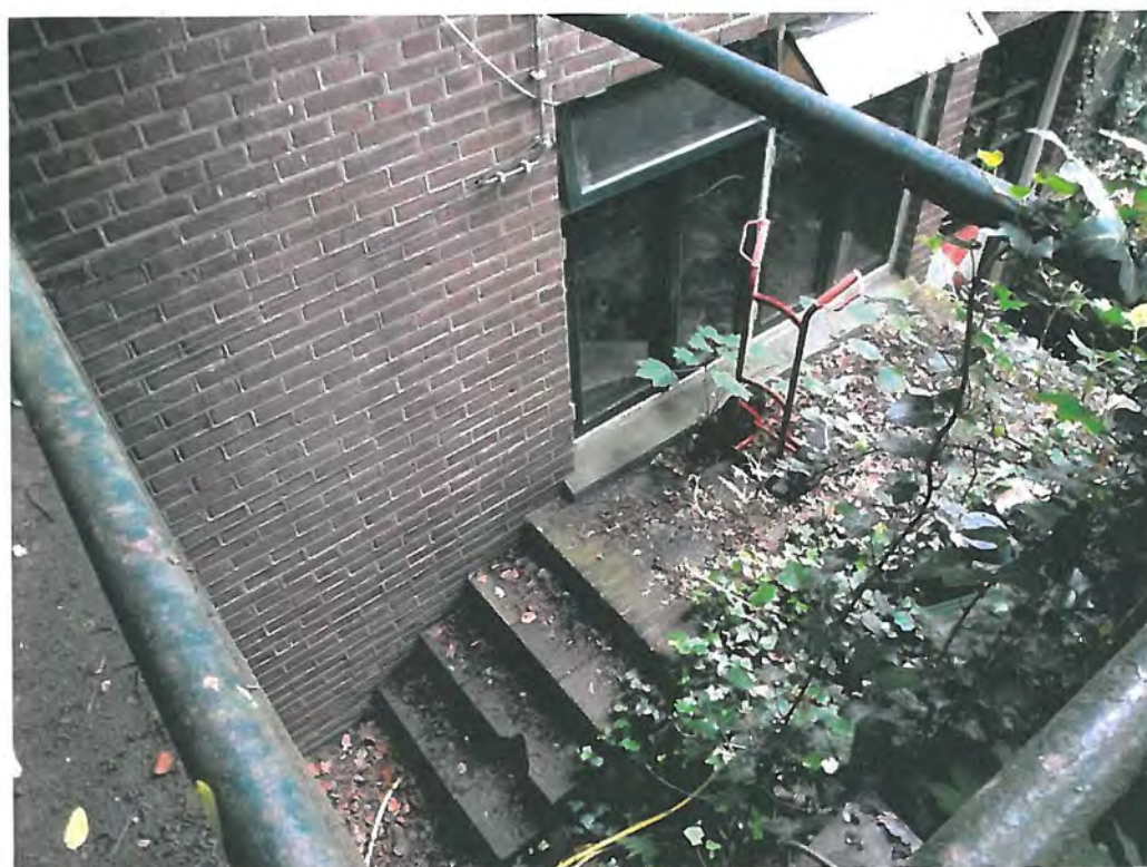
Achtergevel aan Ds. Prinsweg met vermoedelijke dienstingang (boven) en souterrain (beneden)
