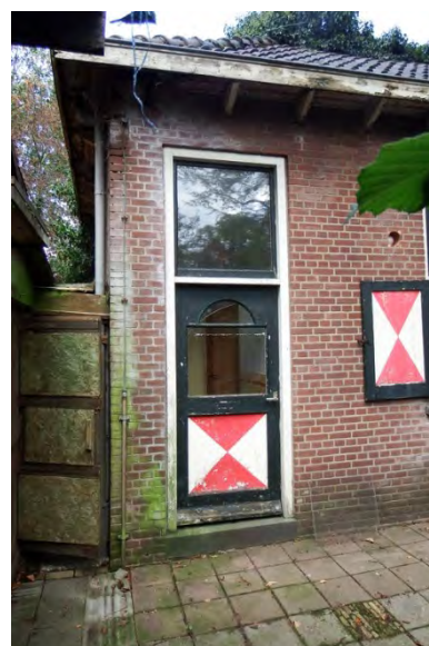
Afb. 13: Toegevoegde deur in de zuidelijke gevel met afwijkende aansluiting van het metselwerk
