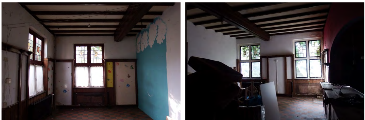
Afb. 30: Vertrekken in de zuidelijke beuk gezien naar het zuiden. De scheidingwand (blauw, foto links) blijkt later te zijn aangebracht: de lambrisering en het moeder- en kinderbintenplafond lopen door. Op de rechter foto geheel rechts de boogvormige doorgangen met barmeubel
