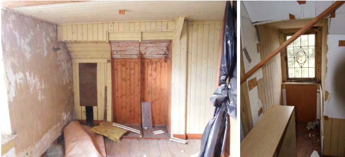
Afb. 37: Achter de topgevel aanwezige kamer met ingebouwde kastruimte (links) en linkerkamer met oorspronkelijk glas in lood raam (rechts).
