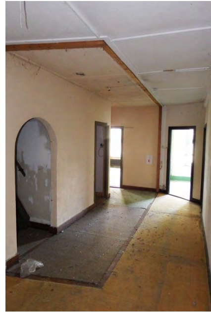
Afb. 14: Zuidelijke gang op de tweede bouwlaag met de restanten van de verwijderde scheidingswand, waardoor het rechter gedeelte op de foto van het hotel werd afgescheiden.
