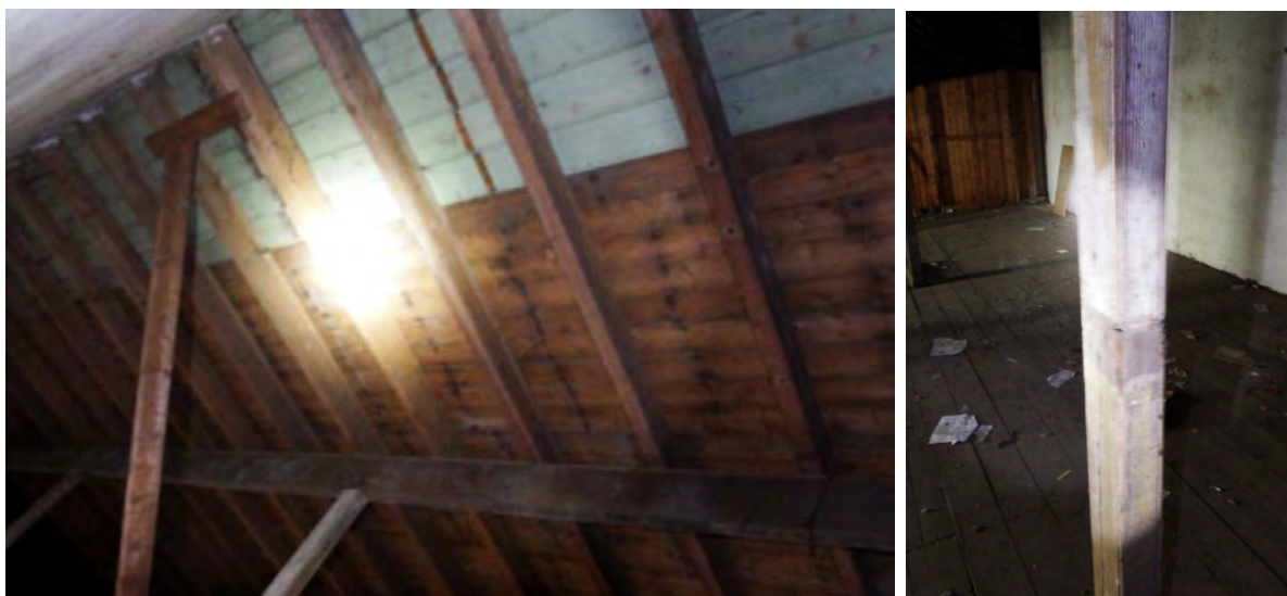
Afb. 36: Hergebruikte geschilderde delen (links) en geschaafde stijl met kraal (rechts).
