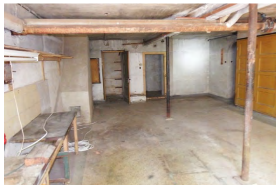
Afb. 18: Noordelijke (links) en zuidelijke (rechts) kelderruimte met ronde stalen kolommen.
