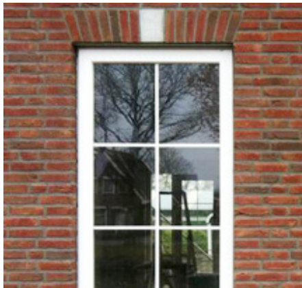
Afb. 42: Detaillering metselverband raampartij
