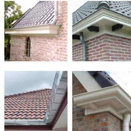
Afb. 53: Mogelijkheden detaillering dakgoot
