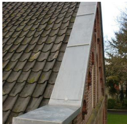
Afb. 39: Zinken daklijst op kopgevel
