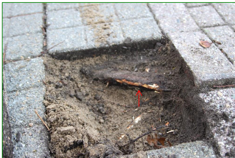
Foto 3: middelgrove wortel met een diameter van 4 centimeter direct onder de elementenverharding en fijne wortels
