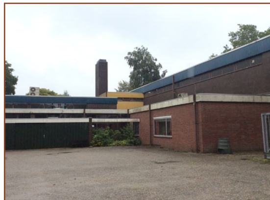
Afb. 2.2: De westzijde van het pand. Vleermuizen kunnen verblijfplaatsen hebben achter de blauwe panelen. Het is niet duidelijk of de vleermuizen de spouw kunnen betreden
