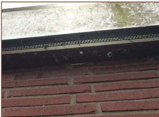
Afb. 2.1: De zijpanelen van het deel dat één verdieping hoog is zijn dichtgezet met fijnmazig gaas. Hierdoor kunnen vleermuizen de panelen niet gebruiken als verblijfplaats
