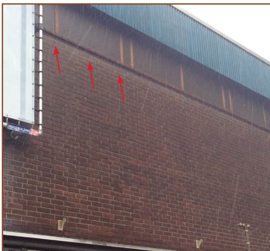
Afb. 2.3: Rondom het gebouw zijn open stootvoegen aanwezig. Vleermuizen kunnen door de stootvoegen de spouw bereiken en gebruiken als verblijfplaats.
