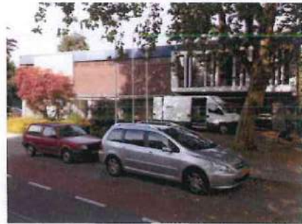
Foto 2: Zuidoostzijde van het kantoor (gelegen aan de Wildforstlaan)
