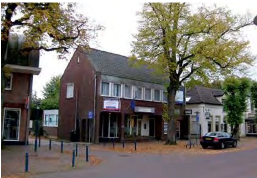
Foto bestaande situatie
