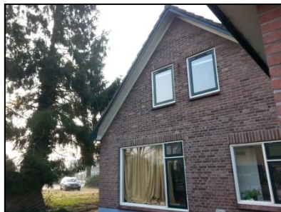
Figuur 4. Achterzijde woning.
