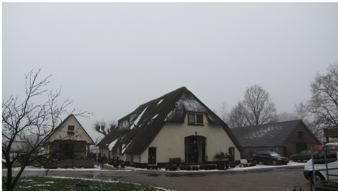
Figuur 8. Het woonhuis, met links het houten tuinhuis en rechts de stenen schuur.
