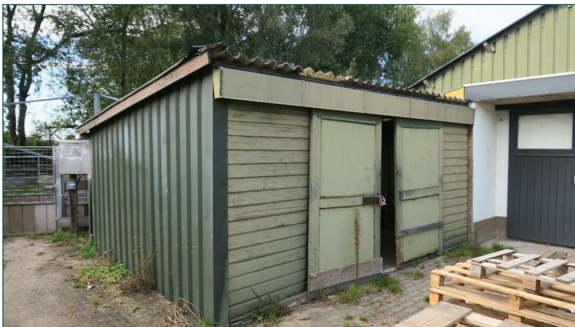
Figuur 3 De overkapping aan de achterzijde van de bestaande schuur. Deze bestaat uit damwandplaten en houten wanden met een golfplaten dak zonder dakbeschot.
