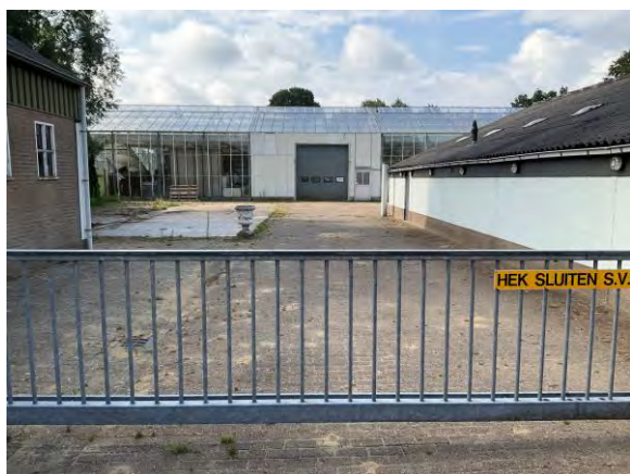
Figuur 8: Dak(goot) bebouwing
