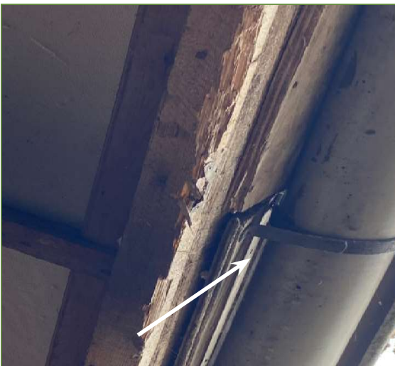
Afb. 2.5 en 2.6 - Het leek mogelijk voor vleermuizen om achterlangs de dakgoot bij schuur 1 in de ruimtes tussen het dak te komen. Dit bleek echter afgedicht door houten latten. Er zijn geen mogelijkheden voor verblijfplaatsen van gebouwbewonende vleermuizen in de te slopen schuren.
