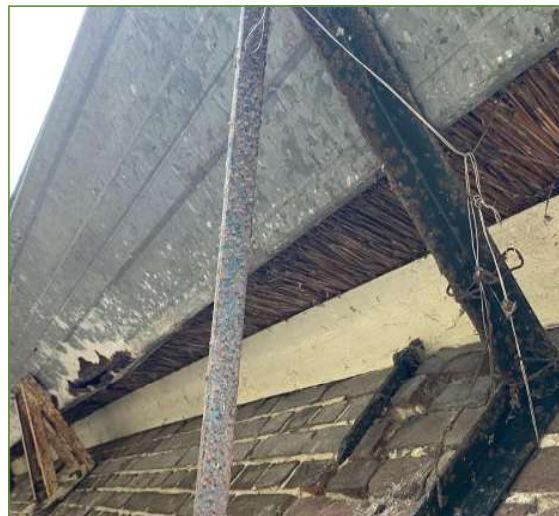
Afb. 2.7 en 2.8 - De betimmering langs rieten dak en muren sluit vrijwel overal nauw aan. Enkele scheuren en kieren bieren geen toegang tot geschikte ruimtes voor gebouwbewonende, beschermde diersoorten als vleermuizen en Huismus.
