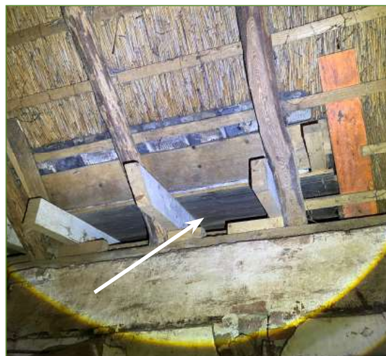
Afb. 2.11 en 2.12 - Overzicht rieten kap bij de deel en aansluiting op het bakhuis. De ruimte onder het platte dak van de aansluiting (witte pijl) is niet van buitenaf bereikbaar.
