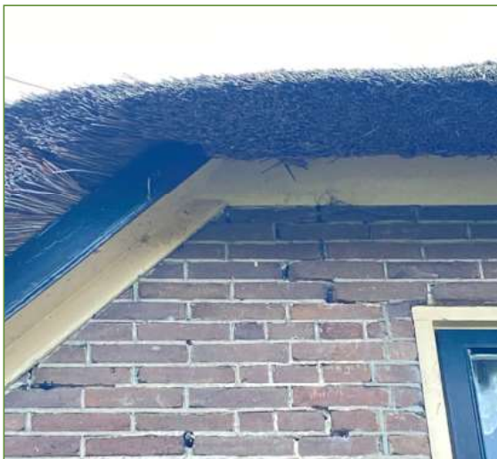
Afb. 2.7 en 2.8 - De betimmering langs rieten dak en muren sluit vrijwel overal nauw aan. Enkele scheuren en kieren bieren geen toegang tot geschikte ruimtes voor gebouwbewonende, beschermde diersoorten als vleermuizen en Huismus.
