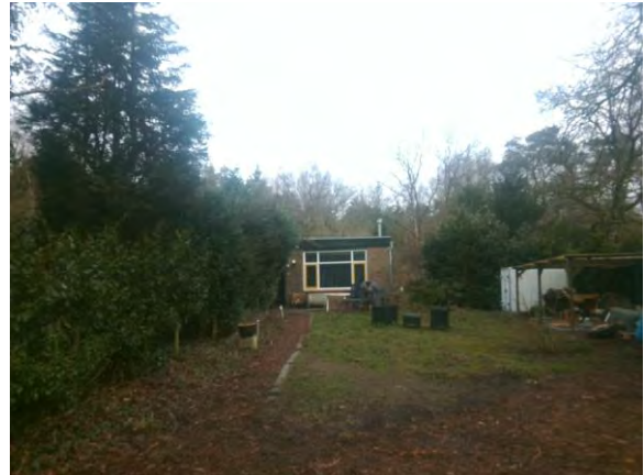
Figuur 6: Overzichtsfoto bebouwing
