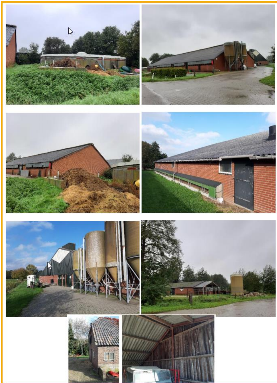
Figuur 3. Foto's bestaande situatie in 2020 (van lb naar ro: aanbouw, loods, kapschuur, binnenkant loods). Al deze opstallen, met uitzondering van de woning (lo), zijn ten behoeve van de plannen reeds gesloopt.
