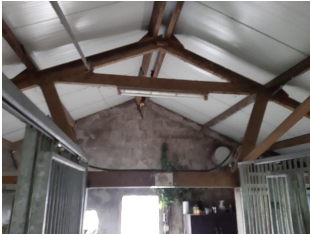
Figuur 4. Foto's van de nog te slopen paardenstal
