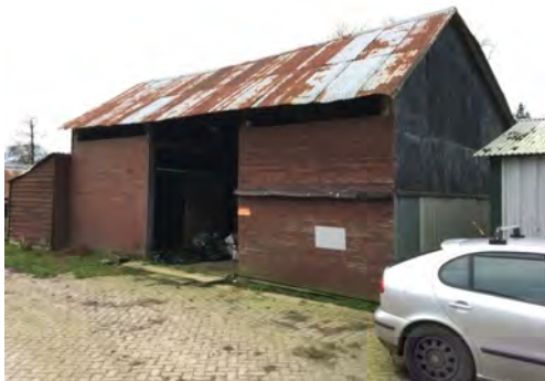
Figuur 11. Schuur ten westen van de woning.
