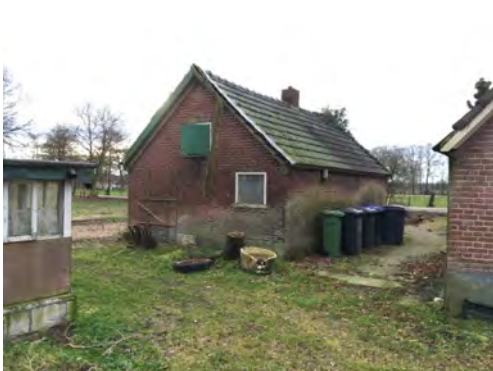
Figuur 5. Stal ten oosten van de woning.
