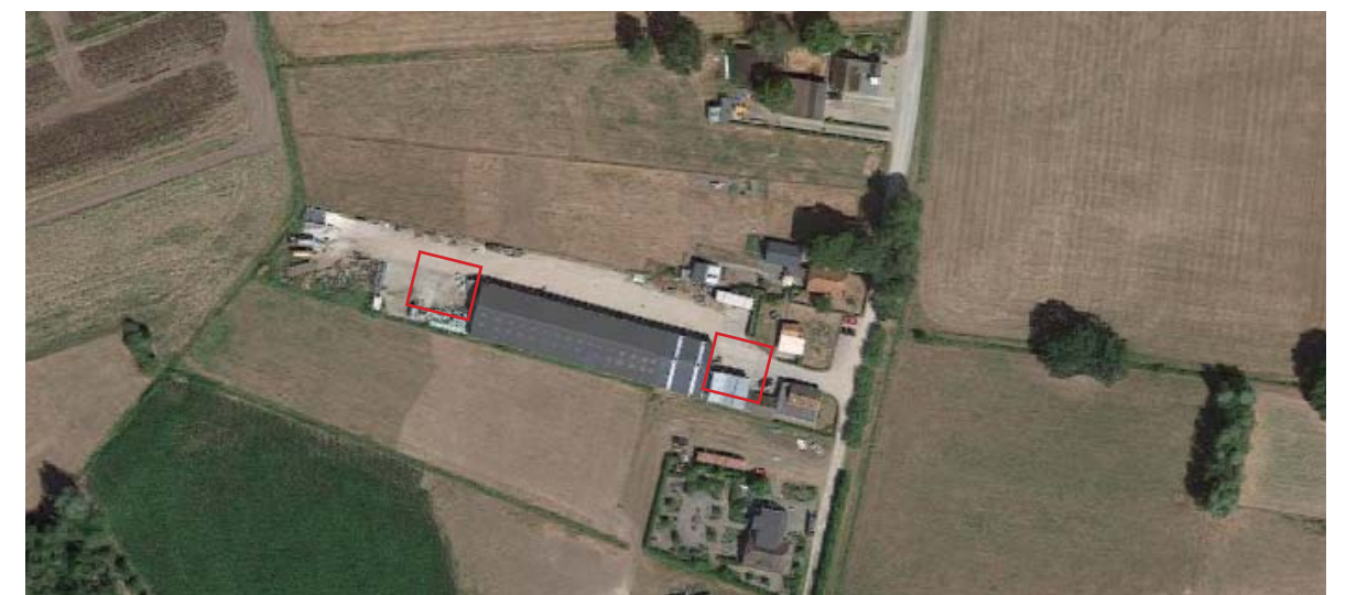
Luchtfoto met de schuur die wordt uitgebreid. De rode kadver geven te mate van uitbreiding weer.
