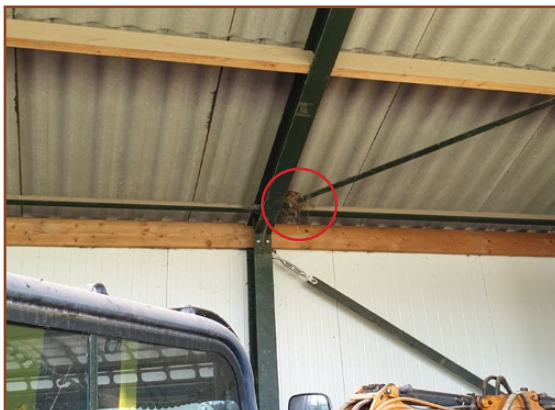
Afb. 2.1: In de uit te breiden schuur zijn nesten aanwezig van waarschijnlijk de huismus. Echter zijn deze nesten verlaten en oud. Tijdens het veldbezoek zijn geen huismussen gezien of gehoord in en rondom de schuur.
