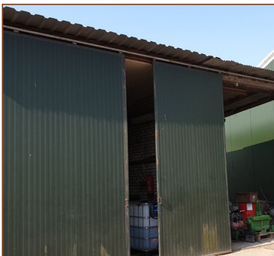
Afb. 2.5: De te slopen schuur. Deze schuur is geïsoleerd en lijkt op het eerste gezicht geschikt voor vleermuizen door de ruimte tussen het golfplaten dak en de isolatie.
