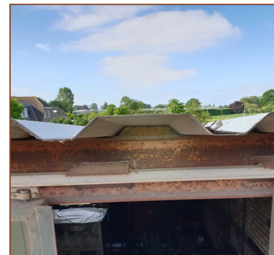
Afb. 2.6: Na verdere inspectie blijkt de ruimte tussen de isolatie en het golfplaten dak dicht gepurd te zijn en daardoor ongeschikt voor vleermuizen.
