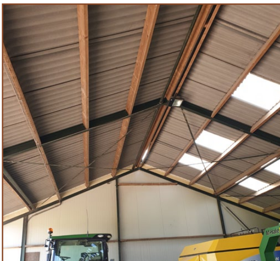
Afb. 2.3: De uit te breiden schuur bevat een golfplatendak zonder dakbeschoet. Hierdoor is het ongeschikt voor vleermuizen.
