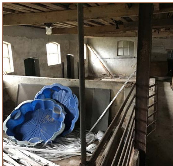
Afb. 2.7: De veeschuur aan de binnenzijde. Sporen van beschermde verblijfplaatsen ontbreken.
