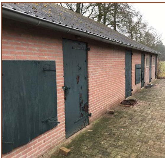
Afb. 2.6: De veeschuur aan de noordzijde: geen Huismus, maar toegankelijke spouw (vleermuizen).
