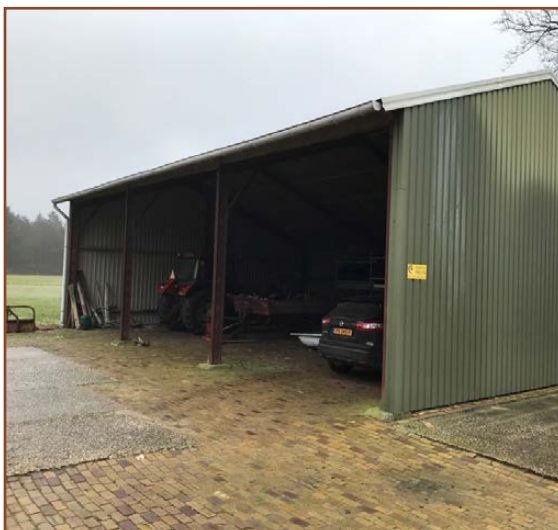
Afb. 2.10: Beeld van de enkelwandige kapschuur, bestaande uit golfplaten en damwandpanelen.
