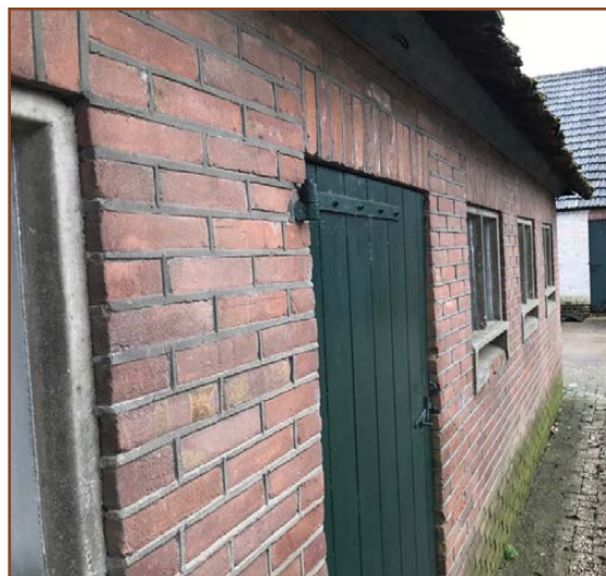
Afb. 2.5: De zijgevel van de boerderij met goed aangesloten dakrand.
