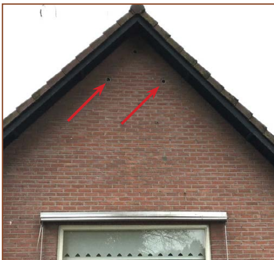
Afb. 2.4: Ventilatiegaten in de gevel zorgen voor toegang tot de spouw (rode pijl).
