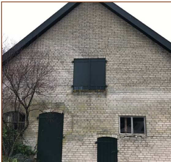
Afb. 2.8: De kalkstenen veeschuur, ongeschikt als vleermuizen-verblijfplaats.
