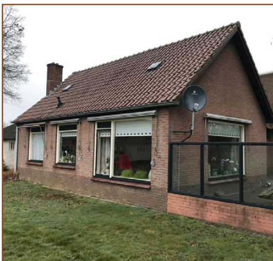
Afb. 2.2: Het bijgebouw bij de boerderij (voormalig kookhuis) dient als tweede woning.
