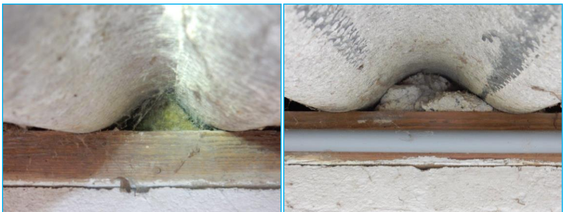
Foto's: Ontoegankelijke openingen bij golfplaten..
