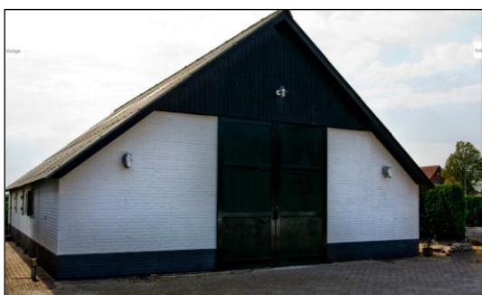
Bestaande vrijstaande schuur
