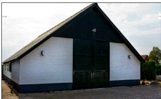
Bestaande vrijstaande schuur
