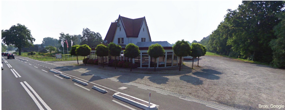
Afbeelding: bestaande situatie perceel Heerderweg 78
