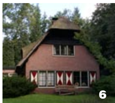
Korrenbergweg 4, Nieuwe Martha's Hoeve
