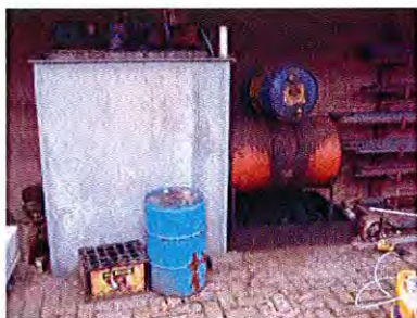
Foto 3: Bovengrondse olietank (afgewerkte olie) met bestaande peilbuis
