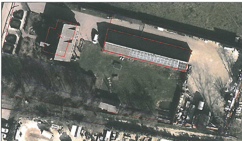
Luchtfoto huidige situatie
