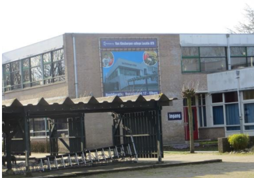
Foto 3 en 4: Schoolgebouw oostzijde
