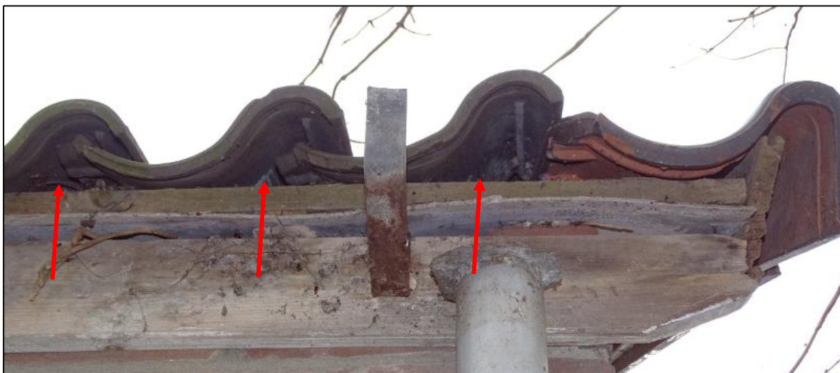
Figuur 4.5 Geschikte verblijfplaatsen onder het dak, invliegopeningen onder de dakpannen.
