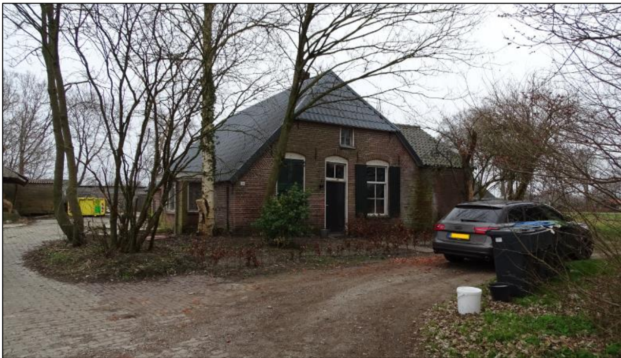
Figuur 1.2 Overzichtsfoto van de woonboerderij, gezien vanuit noordwestelijke richting.
