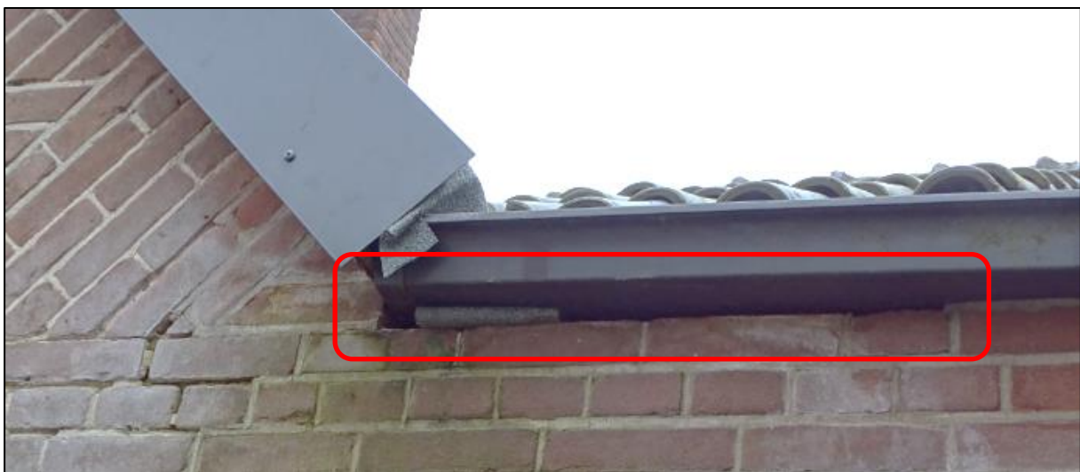
Figuur 4.4 Ruimte tussen muur en dakgoot, geschikte invliegopening vleermuizen.
