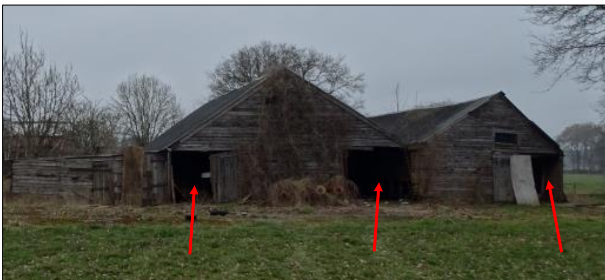
Figuur 4.6 Missende deuren in de schuren biedt vrije toegang voor onder andere vleermuizen.
