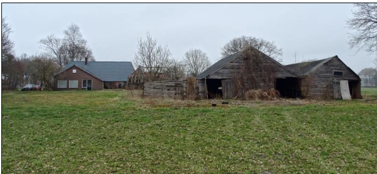
Figuur 1.3 Overzichtsfoto woonboerderij en vervallen schuur en stallen, gezien vanuit zuidwestelijke richting.
