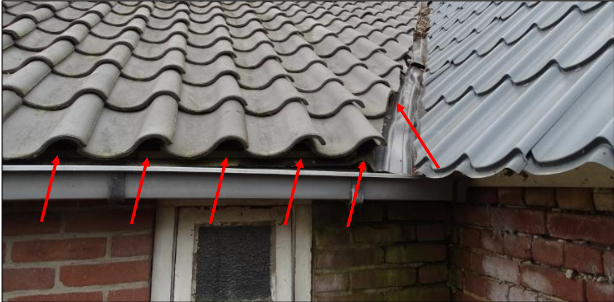
Figuur 4.1 Toegang naar geschikte nestplaatsen onder het dak van de woonboerderij.
