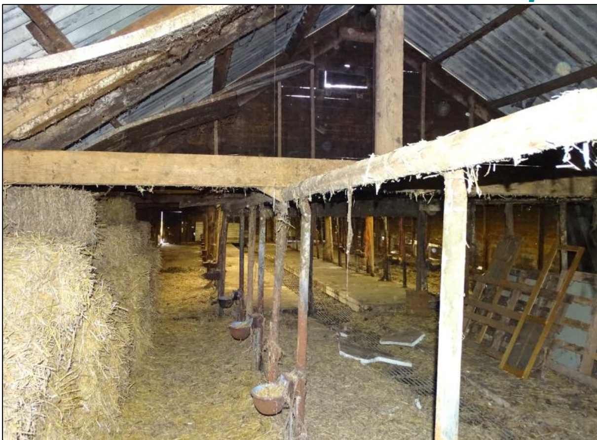
Figuur 1.4 Overzichtsfoto binnenkant van een van de oude koeienstallen.
