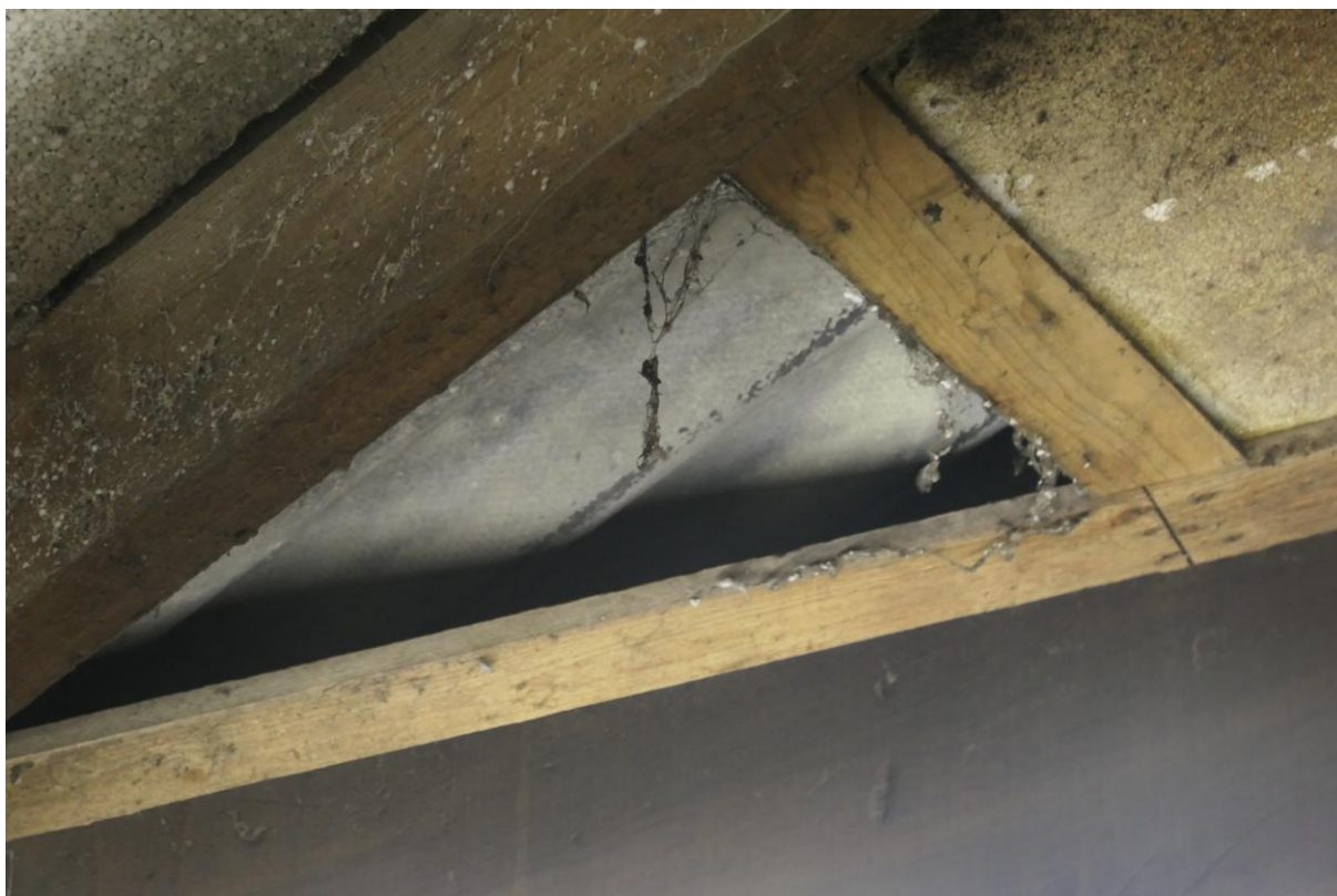
Figuur 4.5 In het plafond van de grote schuur zijn veel gaten aanwezig die voor tocht zorgen (bron: Eco Reest).
