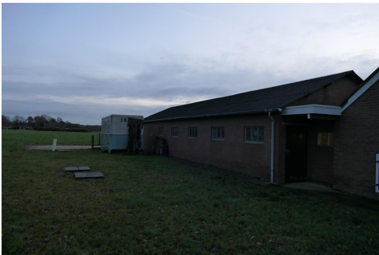
Figuur 1.5 De grote schuur gezien vanuit westelijke richting (bron: Eco Reest).
