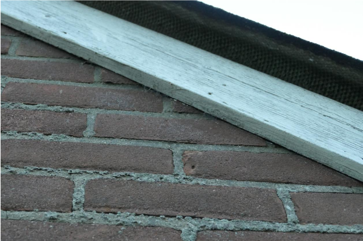
Figuur 4.6 De windveren sluiten goed aan op de gevels (bron: Eco Reest).
