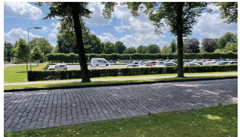
11. De entree van Elburg vanaf de Zwolscheweg wordt gedomineerd door verkeer en parkeren. Aan weerszijden liggen parkeerterrein. Ook is er nog een overloopparkerterrein waar vaak auto's staan. Het is geen hoogwaardige entree voor de vesting.
