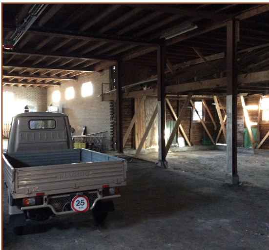
Afb. 2.4: Een gedeelte van de binnenkant van de te renoveren bedrijfshal.
