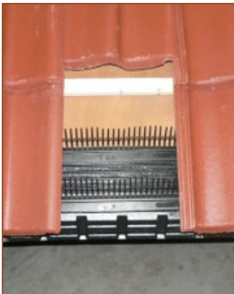
Afb. 4.1: Toepassing vogelvide onder dakpannen. Bron: website Vivara Pro.
