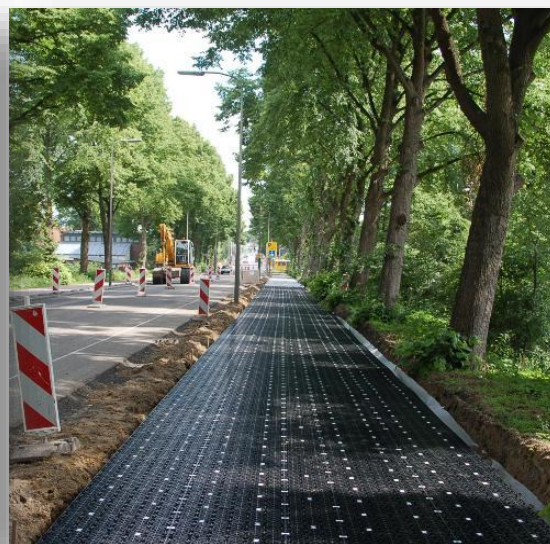
Foto 12: sandwichconstructie onder fietspad (Bron: TGS)
