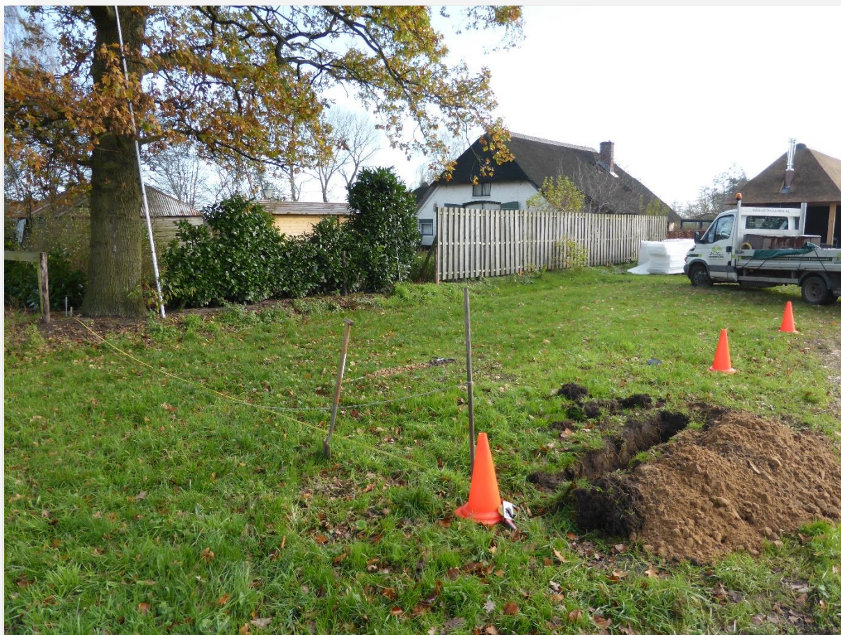
Foto 8: locatie proefsleuf op grens van gepland bouwblok
