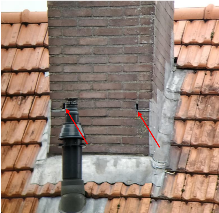
Afbeelding 4.4 Schoorsteen woonhuis met aanduiding mogelijke vleermuisverblijfplaatsen
