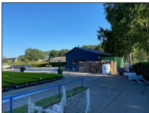
Links: bestaande bedrijfshal.
