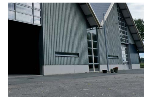
grote overstekken /houten gevel- bekleding/ beton plint
