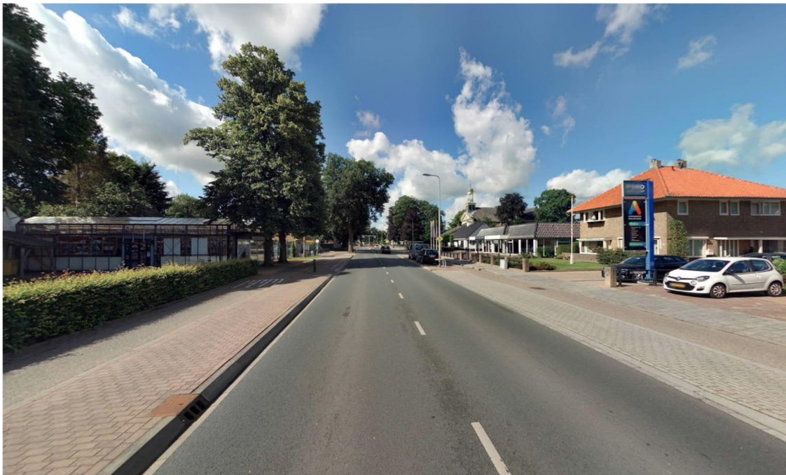
Figuur 4-8: situatie N310 ter hoogte van de ingang voor fietsers richting het voorterrein van het kerkgebouw, links op de foto (Bron: Cyclomedia)
