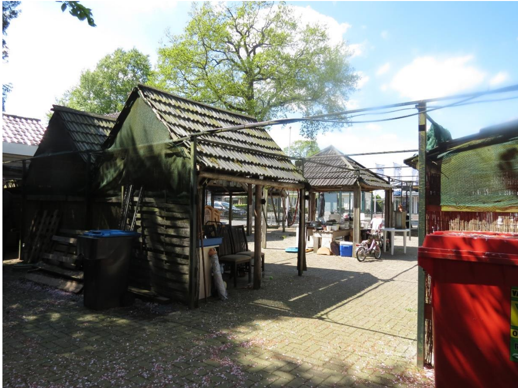
dakpannen zijn gelegd op uitsluitend panlatten en vormen geen verblijfplaats voor de huismus
