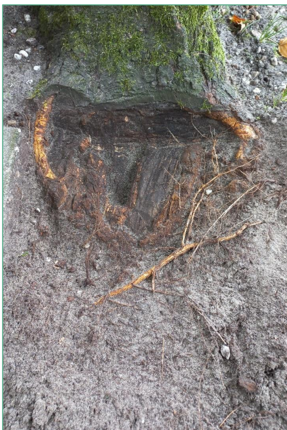
Afbeelding 3.2 Beschadigde wortel, boom 2
