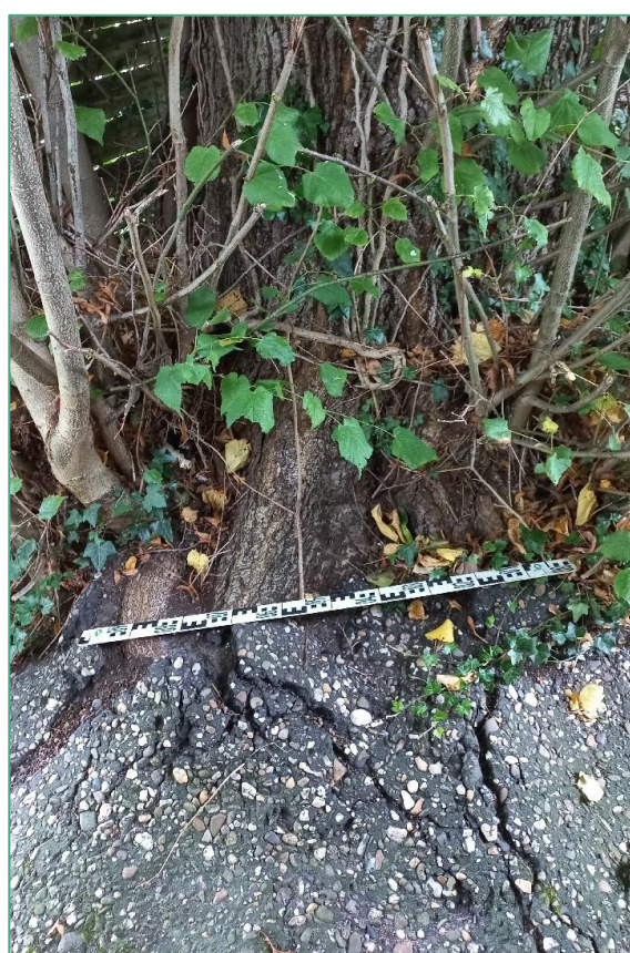
Afbeelding 3.5 Geplaatste asfalt, boom 3
