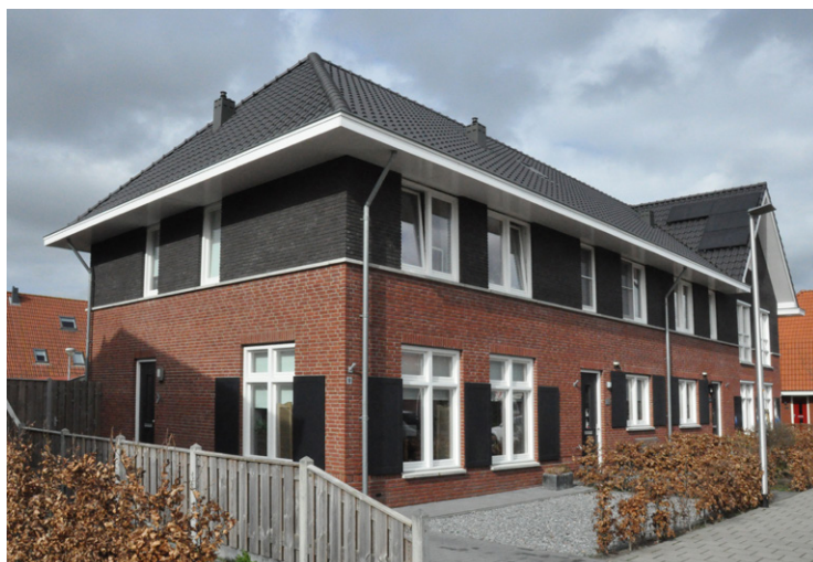
Recent gerealiseerde woningen in Waterlanden I als referentie voor de opbouw van de gevels: roodbruine baksteen als basis, antracietgrijze pannen, witte kozijnen, ramen op verdieping uitgelijnd met ramen begane grond, visuele verlaging bouwvolume door verticale opsplitsing in (maximaal 2) materialen
